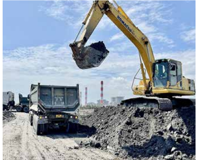
Giai đoạn Thi công và lắp ráp: nguồn phát thải chủ yếu từ vận chuyển vật liệu, tiêu thụ năng lượng tại công trường và chất thải xây dựng
