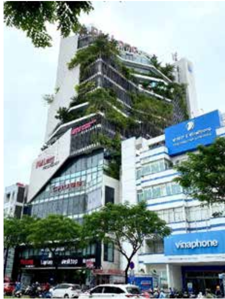
Hình 4. Tòa nhà Phi Long Technology
