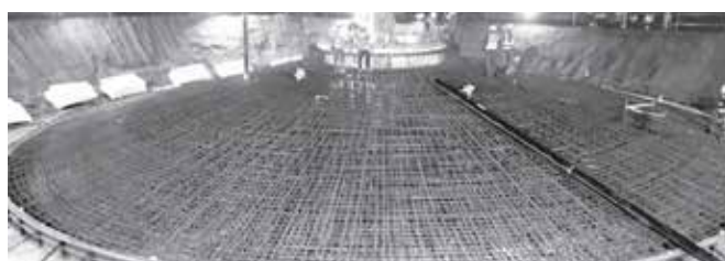
Hình 3. Mặt bằng bố trí thiết bị đổ bê tông móng
