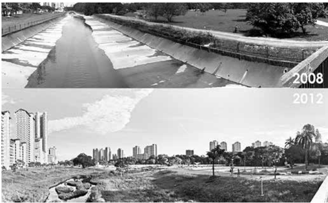
Hình 3. Dự án ABC Waters (Singapore) – chuyển kênh thoát nước bê tông thành dòng sông cảnh quan và vùng trữ nước (Nguồn: PUB Singapore, 2006)
