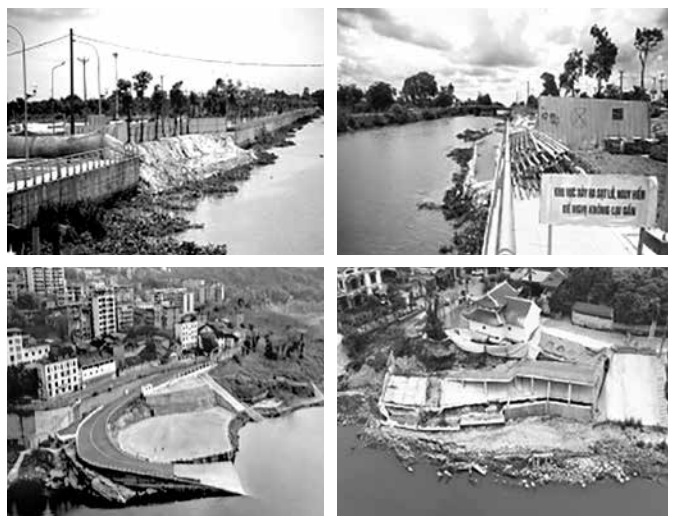
Hình 3. Sạt lở nền đất – nhà ở ven bờ sông khu vực Đồng bằng sông Cửu Long
