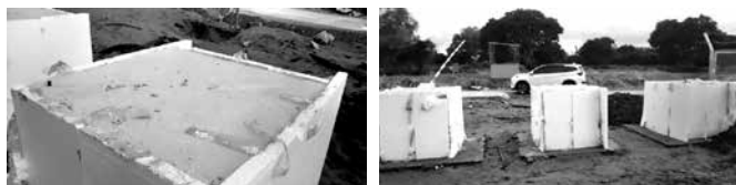
Hình 2. Mẫu đo nhiệt độ tâm khối bê tông, kích thước mẫu 1,6m x 1,6m x 1,6m.
