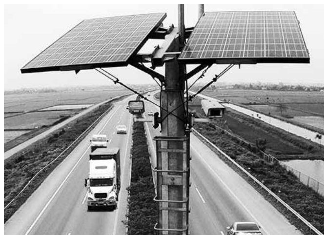
Hình 1. Camera giám sát đường cao tốc qua khu vực nông thôn sử dụng pin năng lượng mặt trời
