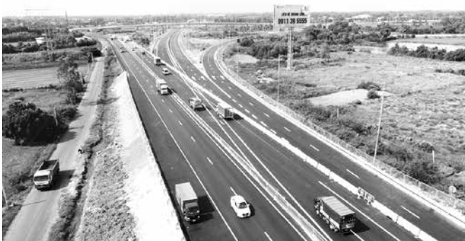
Việc thiếu đất đắp nền xảy ra ở DA cao tốc Trung Lương – Mỹ Thuận đã làm đình trệ công trình một thời gian dài
