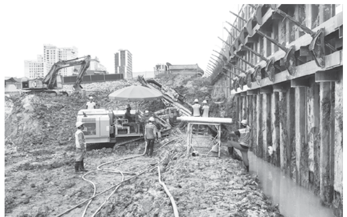
Neo trong đất là giải pháp hiệu quả ổn định hố đào sâu như: Móng hố đào nhà cao tầng, công trình ngầm dân dụng, đập thủy điện,...
