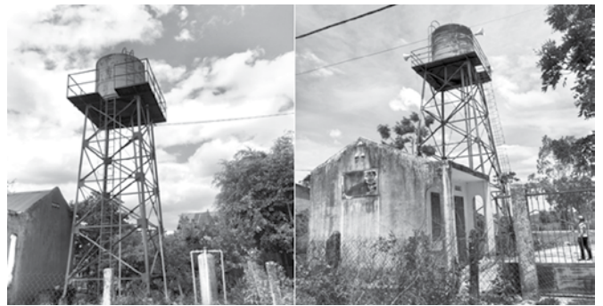
Hình 1: Công trình CNTTNT EpRi, xã Ea Set, Buôn Đôn, tỉnh Đắk Lắk
