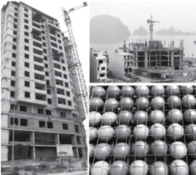
Hình 1: Mô tả trình tự thi công sàn bóng nhựa
