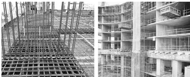
Hình 3. Thi công dầm chuyển trong thực tế
