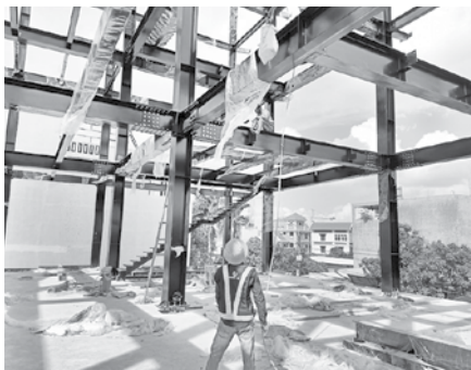
Hình 1. Khung thép nhà dân dụng thấp tầng
