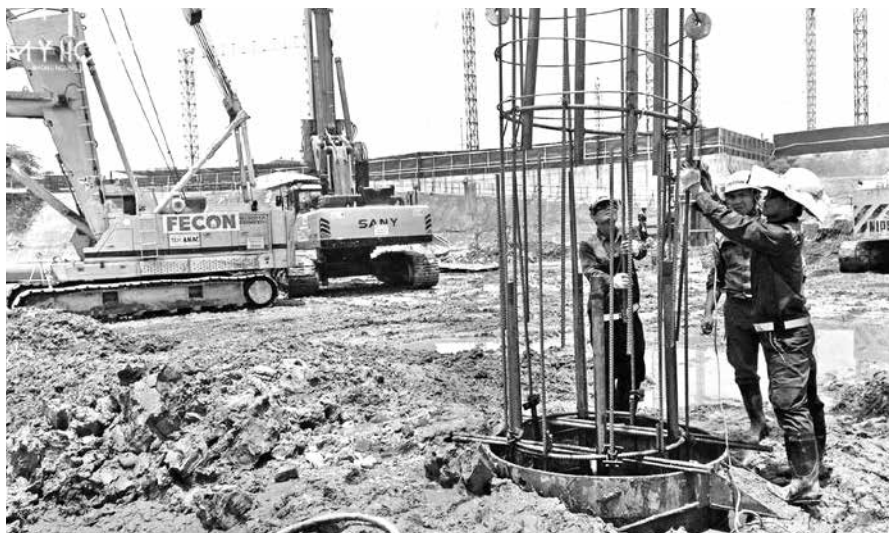
Cần hạn chế chiều cao rơi bê tông và tốc độ đổ bê tông
