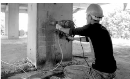
Khoan kiểm tra chất lượng bê tông kết cấu
