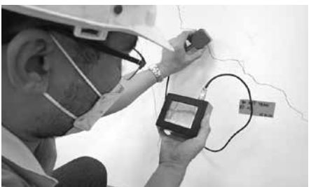
Khảo sát hiện trạng lún nứt
