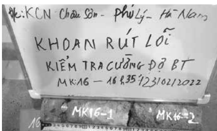
Khảo sát nền bê tông nhà xưởng
