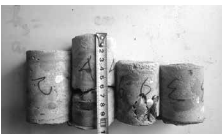
Mẫu bê tông sàn bị rỗ đáy, hở thép
