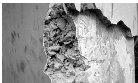
Bê tông kém chất lượng thép bắt đầu gỉ
