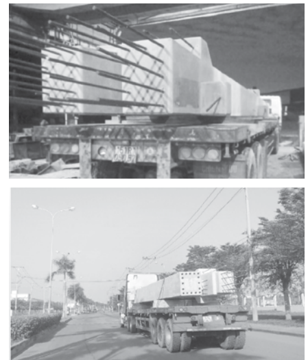
Hình 2.10. Quá trình vận chuyển các loại cấu kiện đến công trình (Nguồn: Công ty TNHH DPM Việt Nam)
