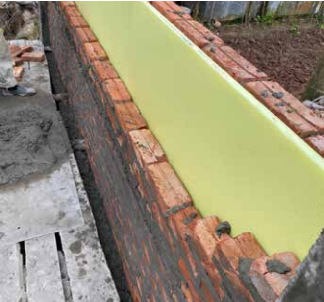
Hình 8. Xây tường kết hợp tấm cách nhiệt EPS
