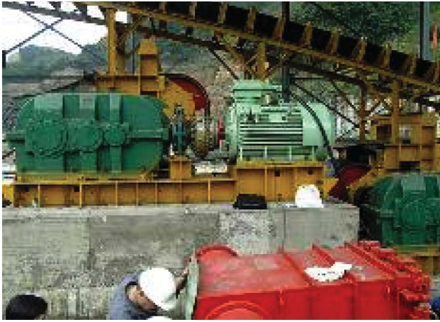
Lắp ráp băng tải dọc lòng máng sâu của Viện Cơ khí Năng lượng và Mỏ
