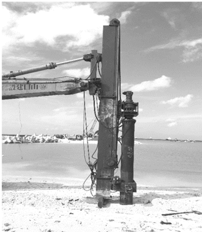
Hình 1. Thiết bị hạ cọc tại công trường
