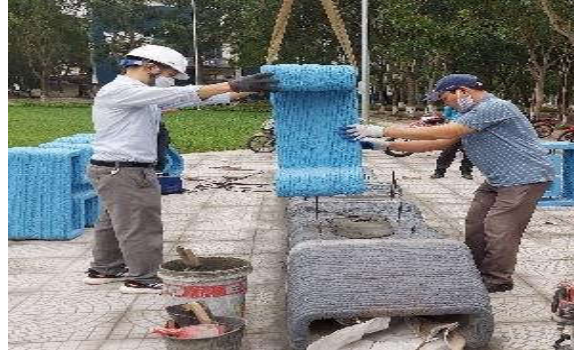
Hình 19: Quá trình lắp dựng
