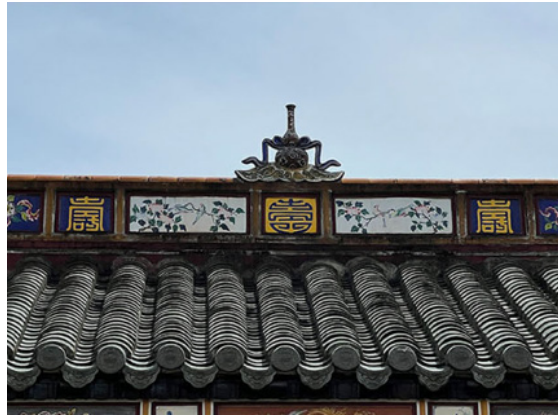
Hình 5: Ngói ống lợp và ngói trích thủy trang trí trên diềm mái các công trình kiến trúc cung đình Huế.
