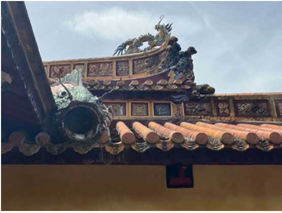
Hình 5: Ngói ống lợp và ngói trích thủy trang trí trên diềm mái các công trình kiến trúc cung đình Huế.
