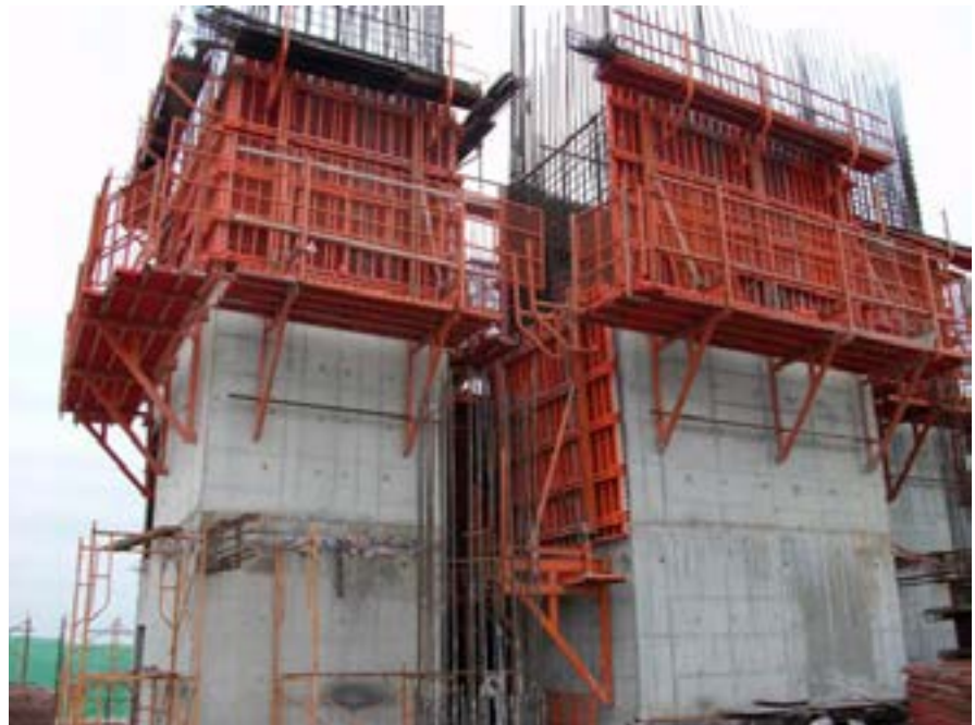
Hình 1. Sử dụng ván khuôn leo trong thi công
