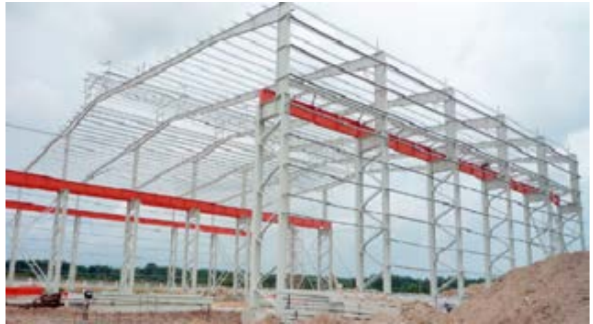
Hình 1. Kết cấu cột rỗng 2 nhánh
