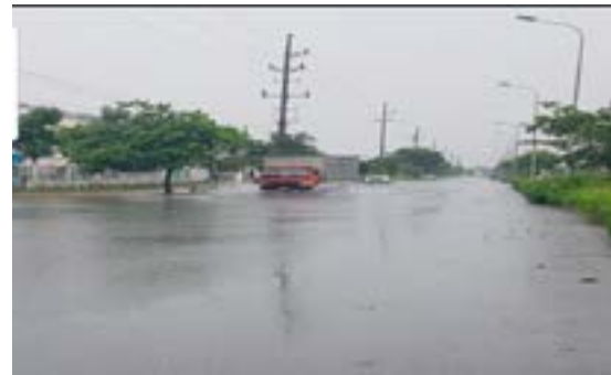
Hình 4. Ngập úng dềnh nước khi mưa lớn tại KCN
