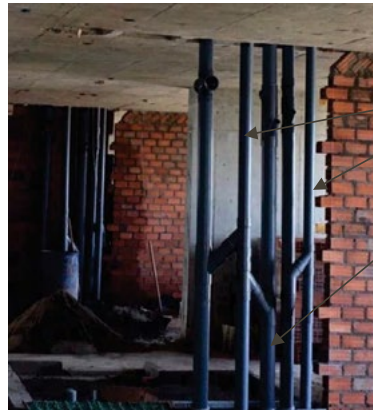
Hình 2. Sơ đồ có ống đứng thông hơi phụ
