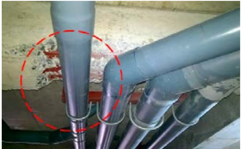
Hình 1: Xung đột giữa các bộ môn trong thi công ảnh hưởng đến chất lượng công trình
