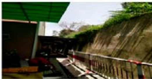
Hình 9. Mái dốc đã được xử lý theo phương pháp “đỉnh đất”, phần tường bê tông dưới dày 10cm, nửa trên được bảo vệ bằng các ô địa kỹ thuật để trồng cỏ tạo thành thảm bảo vệ. Hình ảnh chụp năm 2023 tại số 33 Nguyễn Văn Cừ, Phường 1, thành phố Đà Lạt [6]
