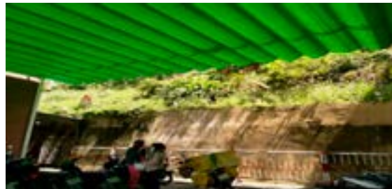
Hình 9. Mái dốc đã được xử lý theo phương pháp “đỉnh đất”, phần tường bê tông dưới dày 10cm, nửa trên được bảo vệ bằng các ô địa kỹ thuật để trồng cỏ tạo thành thảm bảo vệ. Hình ảnh chụp năm 2023 tại số 33 Nguyễn Văn Cừ, Phường 1, thành phố Đà Lạt [6]
