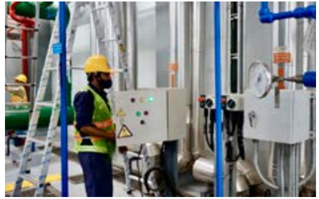
Hình 4. Lò đốt rác thải sinh hoạt thu hồi nhiệt phát điện công suất 5MW
