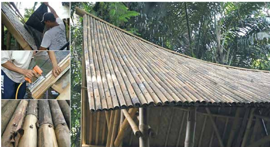
Hình 8. Kỹ thuật lợp mái từ tre chẻ đôi
