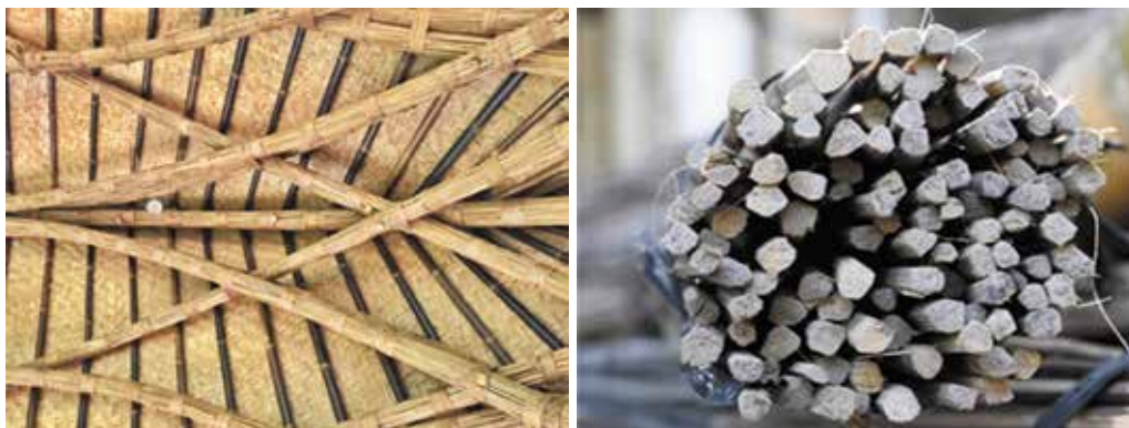
Hình 3. Kỹ thuật chẻ nan hình trụ và uốn theo bó nan
