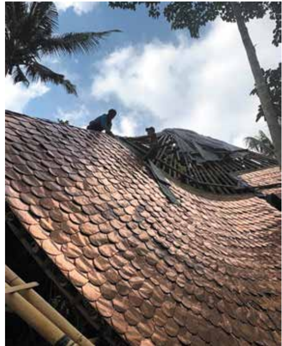
Hình 11. Mái lợp bằng đồng
