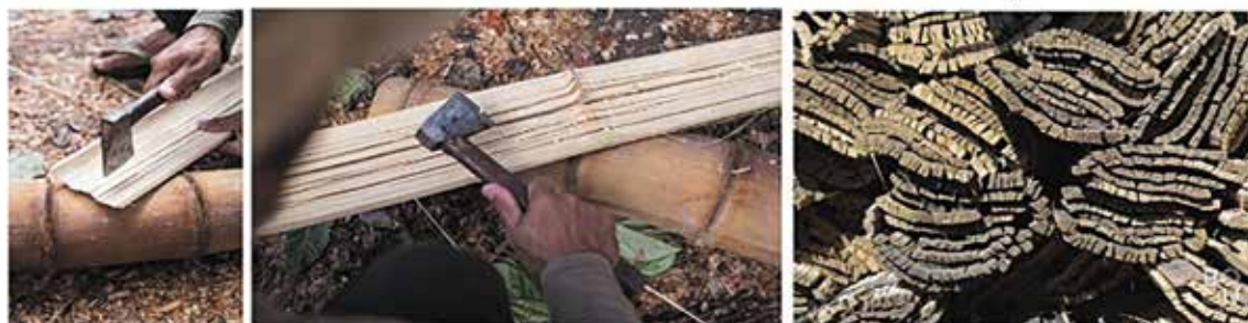
Hình 10. Cách thi công và tạo hình mái công trình bằng tre đọt
