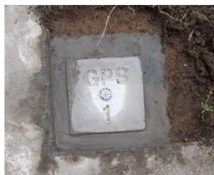
Hình 2: Công tác xây dựng mốc khống chế mặt bằng
