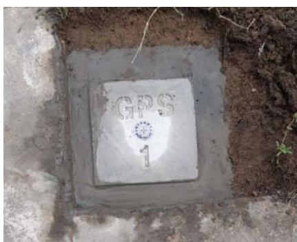
Hình 2: Công tác xây dựng mốc khống chế mặt bằng
