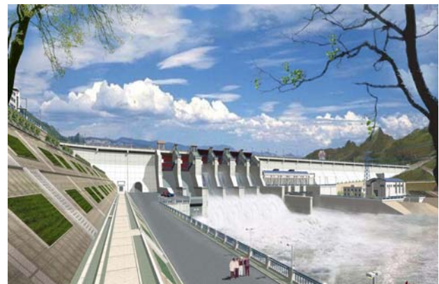
Hình 12. Giải pháp xử lý bề mặt các sườn dốc hai bên bờ hạ lưu ở đập Định Bình
