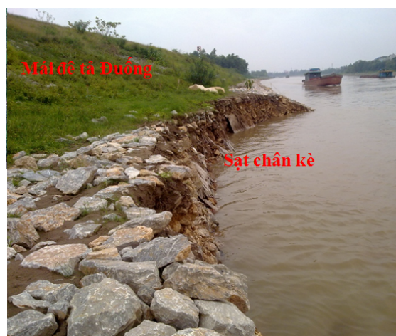
Hình 1. Đoạn kè Xuân Canh bờ tả sông Đuống bị sạt lở tháng 12/2012
