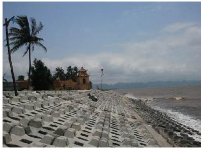
Mái đê đoạn K2+000-K2+800 được gia cố bằng cấu kiện Holhquader
