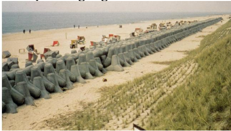
Hình 3. Lãng thể Tetrapod bảo vệ công trình đê biển, đụn cát trong bão
