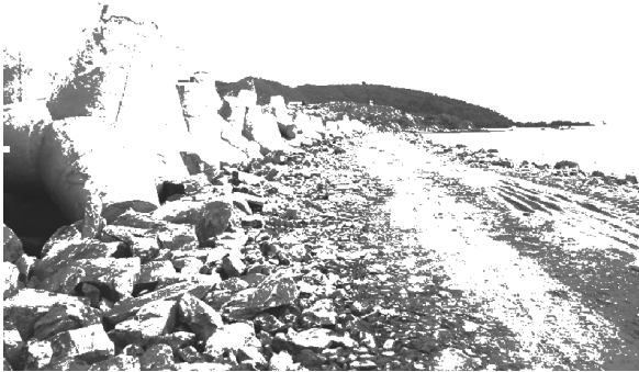
Hình 2: Công trình ngăn dòng thành công vào ngày 25 tháng 10 năm 2012.
