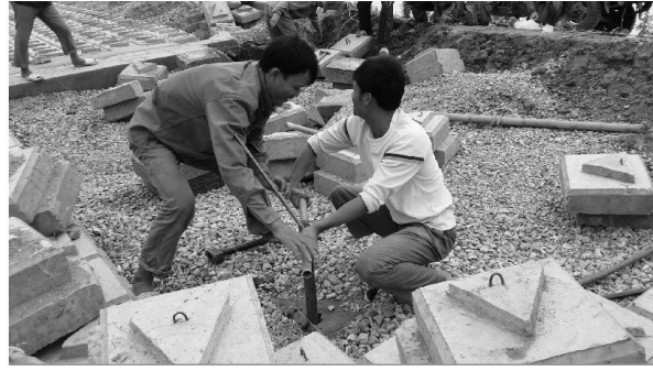
Hình 2 : Lắp neo vào tuýp bắt neo và xoáy neo vào mái đê đến độ sâu thiết kế
