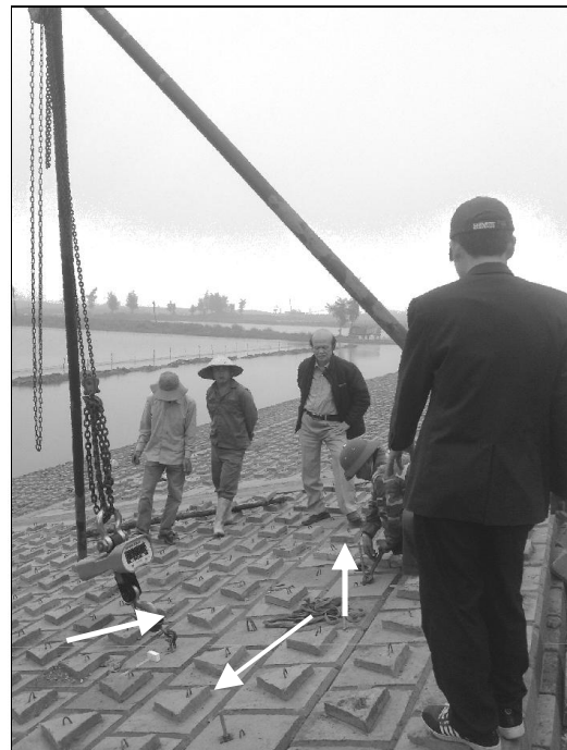
Hình 5: Lắp mảng gia cố và xiết ốc
