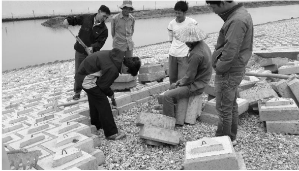
Hình 2 : Lắp neo vào tuýp bắt neo và xoáy neo vào mái đê đến độ sâu thiết kế
