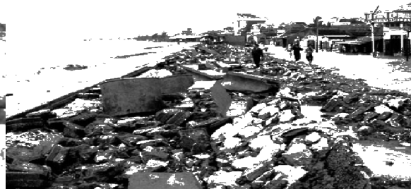
Hình 1. Đê biển Hậu Lộc, Thanh Hóa hư hỏng do bão số 7 năm 2005 (nguồn Internet)
