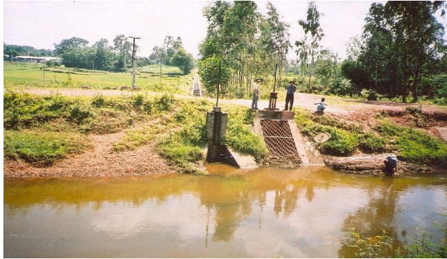
Hình 3.4. Cửa lấy nước từ kênh chính Núi Cốc vào Nhà máy nước Tích Lương
