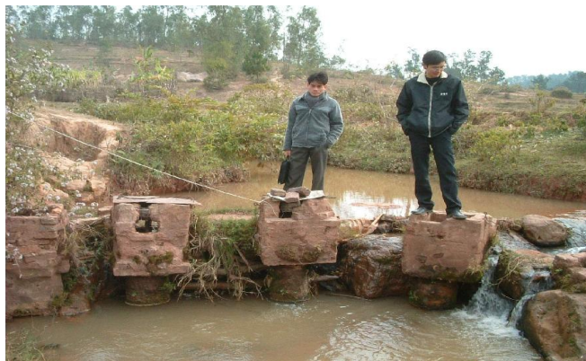
Hình 3.2. Thủy điện gia đình trên kênh Tà Keo – Nà Cáy
