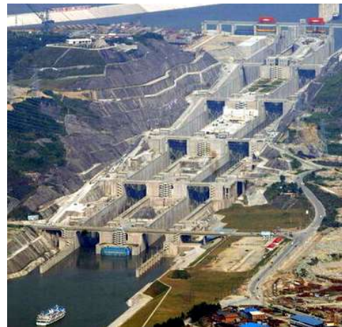
Hình 1: Công trình âu thuyền hai luồng năm cấp liên tục
