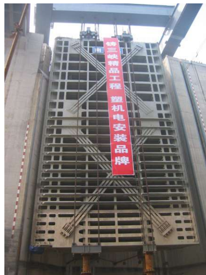
Hình 10: Kết cấu cánh cửa van
