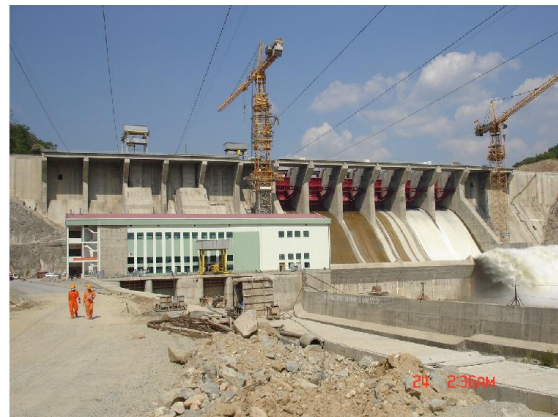
Hình 1. Thủy điện Sê San 3 nhìn từ hạ lưu
