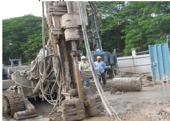
Hình 3. Máy khoan trộn sâu hai pha áp lực cao đang gia cố nền hầm đường bộ Kim Liên (2007)
