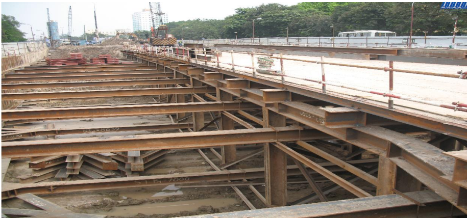
Hình 5. Hệ thống chống đỡ mái hố móng khi có sàn công tác tại hầm đường bộ Kim Liên
