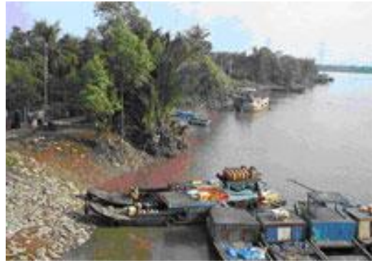
Hình 3. Cát nhà, trồng cây lán chiếm đê bao, neo đậu tàu thuyền lán chiếm phạm vi an toàn của CTTL ở An Giang, Vĩnh Long
