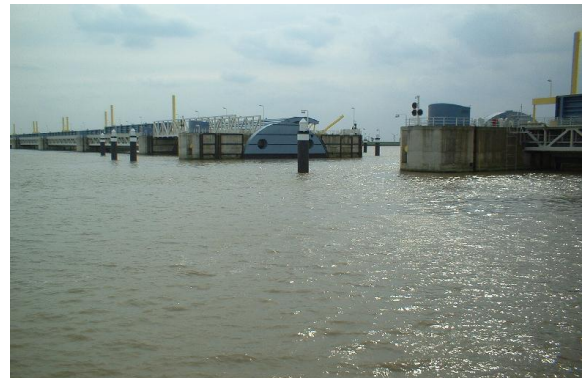
Hình 9: Công trình ngăn sông EMS – Đức
