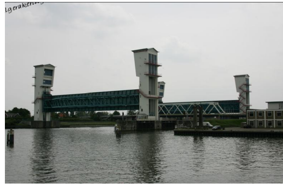
Hình 5: đập chắn sóng Hollandse Ijsel
