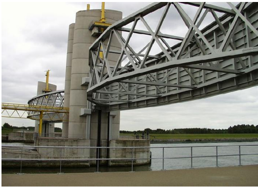
Hình 4: Công trình ngăn sông Hartel – Hà Lan
