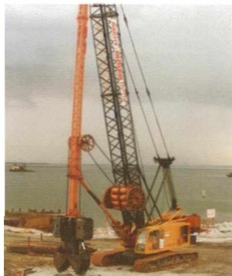
Hình 1 Thi công hào Bentonite
