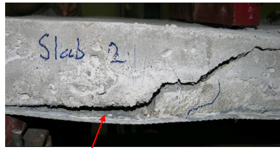
Vết nứt bị mở rộng ở trạng thái phá hoại
