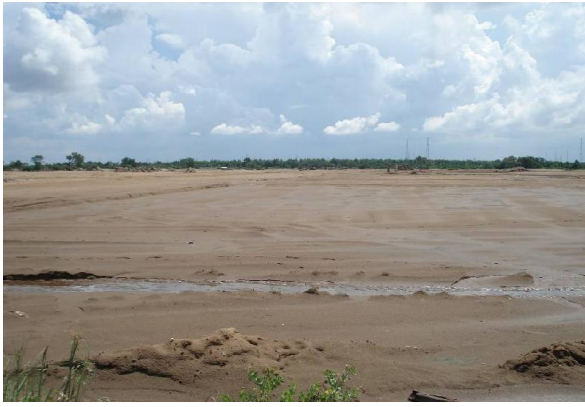
Hình 2: Thi công hoàn thiện từng lớp
