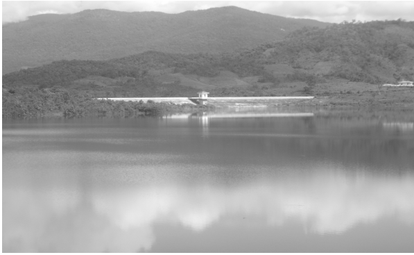
Hệ thống thủy lợi hồ Trà Co hoàn thành 2011, có dung tích chứa 10 triệu m 3 nước cung cấp cho 1.050 ha đất nông nghiệp và phục vụ sinh hoạt
