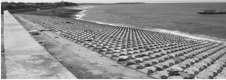
Hình 3.2: Kè bảo vệ thôn 5 xã Tam Thanh huyện Phú Quý
