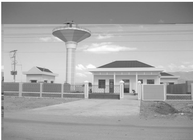
Hình 2. Nhà máy cấp nước sinh hoạt xã Phương Cù (tỉnh Ninh Thuận)
