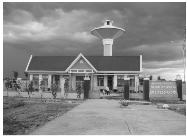
Hình 3. Nhà máy cấp nước khu thị tứ Phước Hậu (tỉnh Ninh Thuận)
