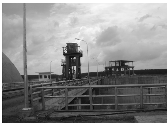
Đập chính và cửa lấy nước Hồ chứa Phước Hòa đang được xây dựng- Nguồn vốn của ADB ( 9/2011)
