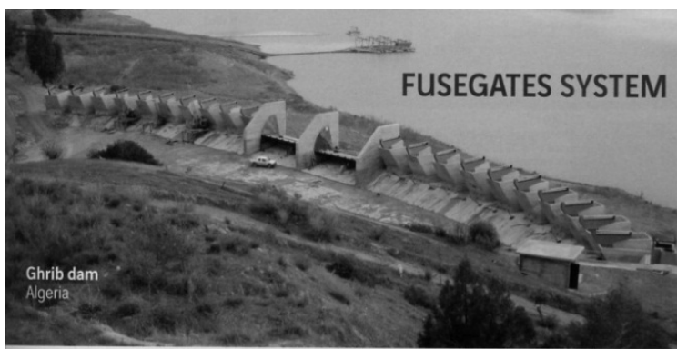
Hình 1. Đập tràn Ghib (Algeria)
